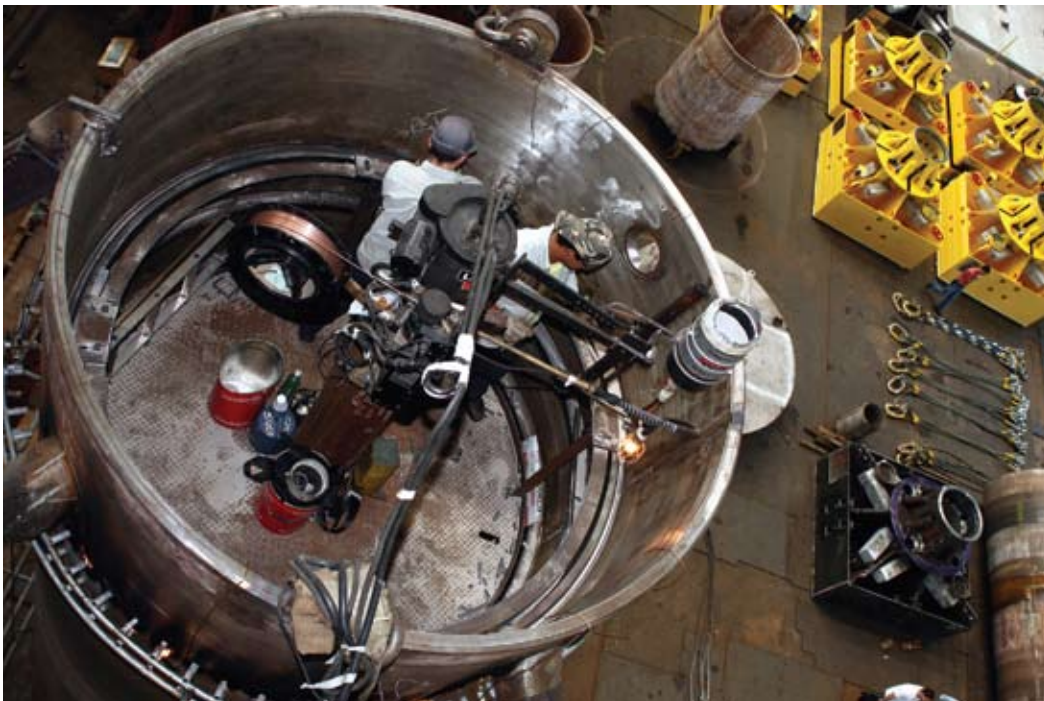
▼ Fabricação parcial de costado de reator de alta pressão em cromo molibdênio para HDT/HDS.
