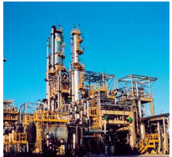
▼ Ampliação e modernização da Refinaria Isaac Sabbá (Reman), em Manaus, AM, com aumento da capacidade de 2.500 m 3 para 7.500 m 3 , incluindo o fornecimento e instalação da nova unidade de destilação atmosférica.
