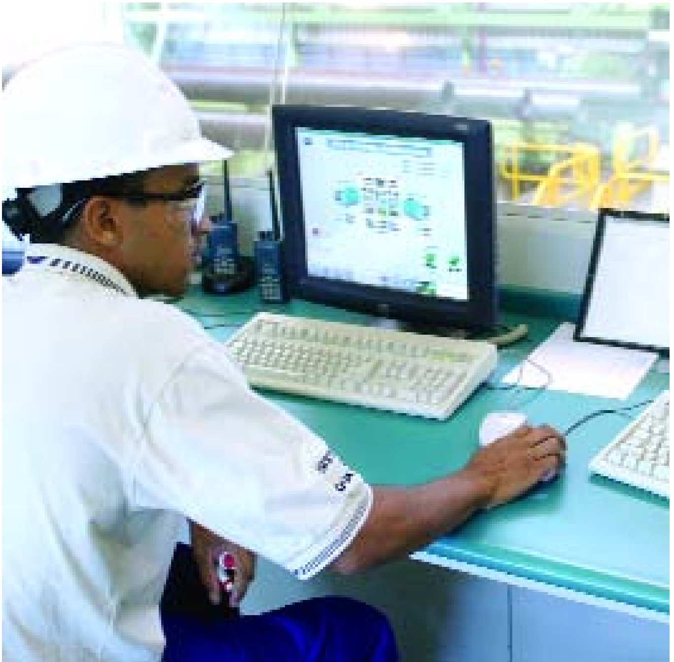
Planta de Tratamiento Térmico. 8h
